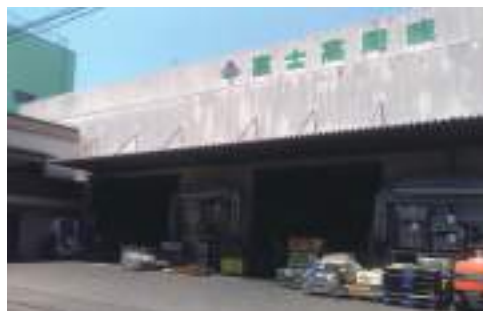
本社工場(高周波工場)
