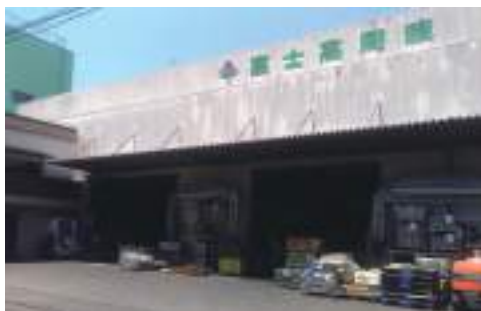
本社工場(高周波工場)
